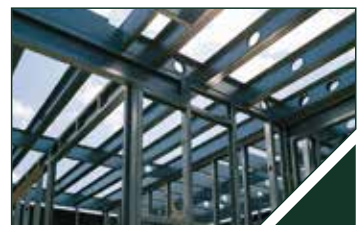
Çelik Konstrüksiyon Construcción de acero
